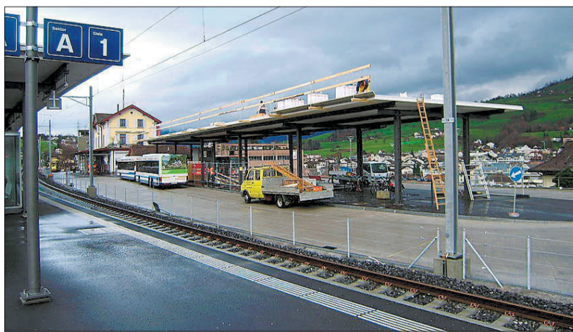
Zurzeit wird am neuen Busbahnhof das Dach montiert.
