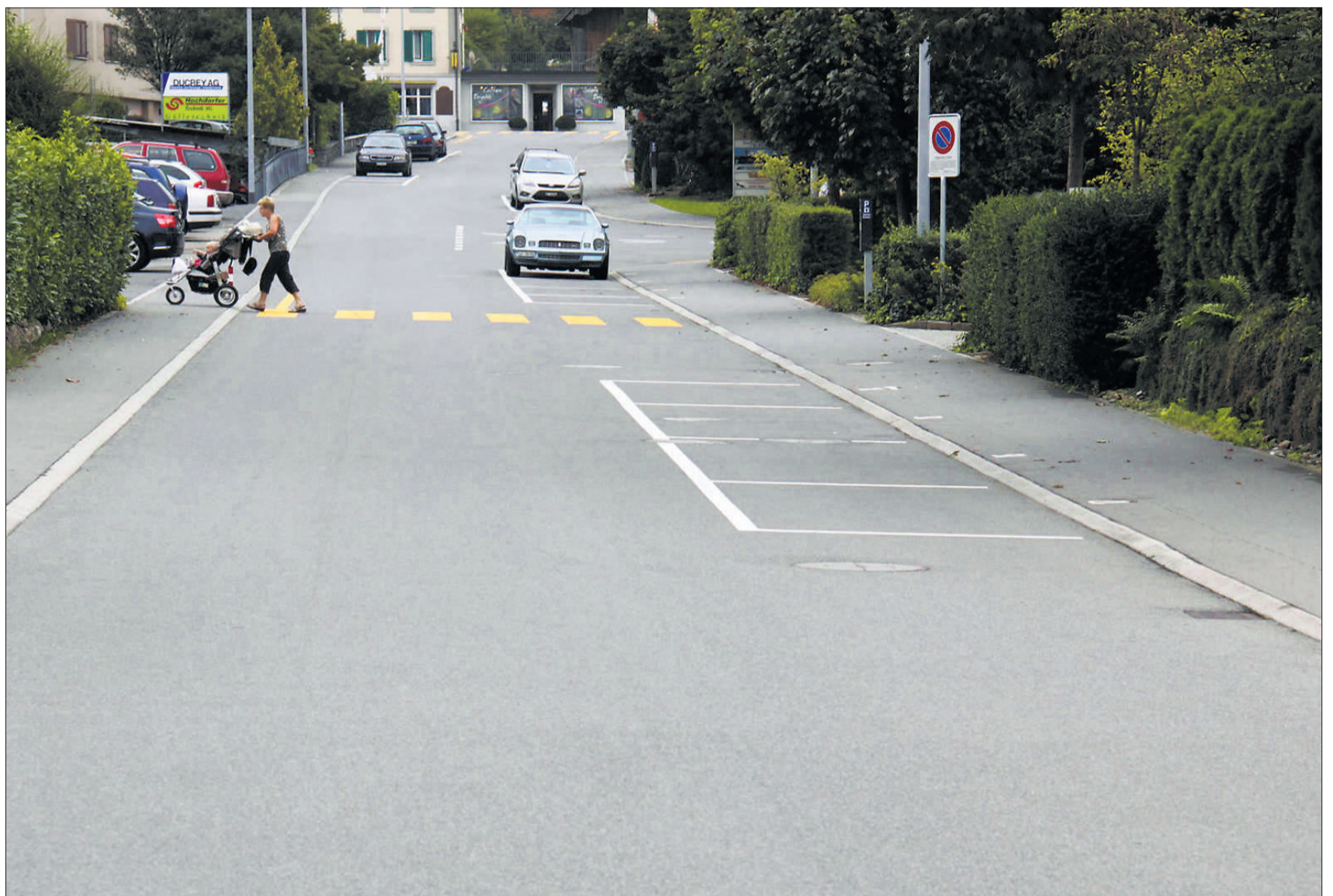
Auf der Siegartstrasse in Küssnacht wird bald eine Tempo-30-Zone installiert. PD
