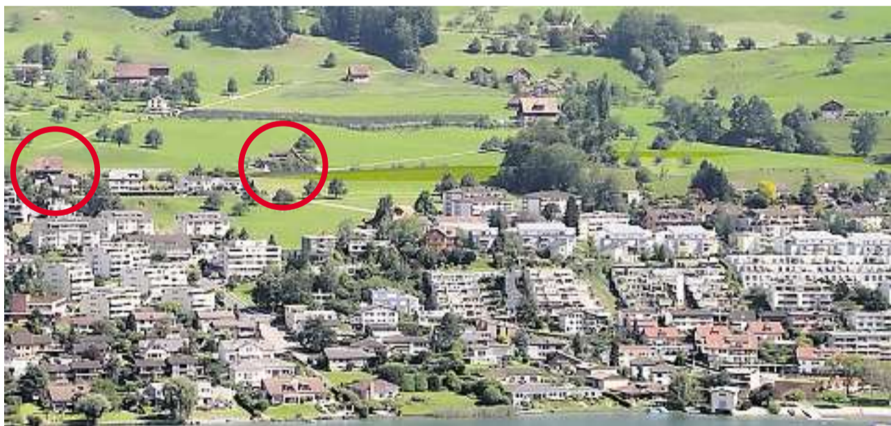
Aussicht von der Allmig auf die Gebiete Stadelmatt und Breitfeld: Der Abschnitt zwei befindet sich bei der Stadelmatt auf einer Dammlage und im Gebiet Breitfeld im Einschnitt (Bildmontage grüner Streifen). Der Bauernhof Stadelmatt befindet sich im roten Kreis links, der dazugehörige Stall im roten Kreis rechts.
