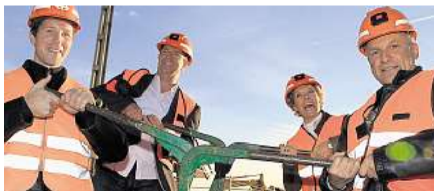
Aufgeleitet: Symbolisch verrichten Projektleiter Stefan Betschart, die Bezirksräte Sepp Heinzer und Carole Mayor sowie SBB-Regionalleiter Ernst Ziegler (von links) die ersten Gleisarbeiten am neuen Bahnhof. Bild Bruno Facchin
