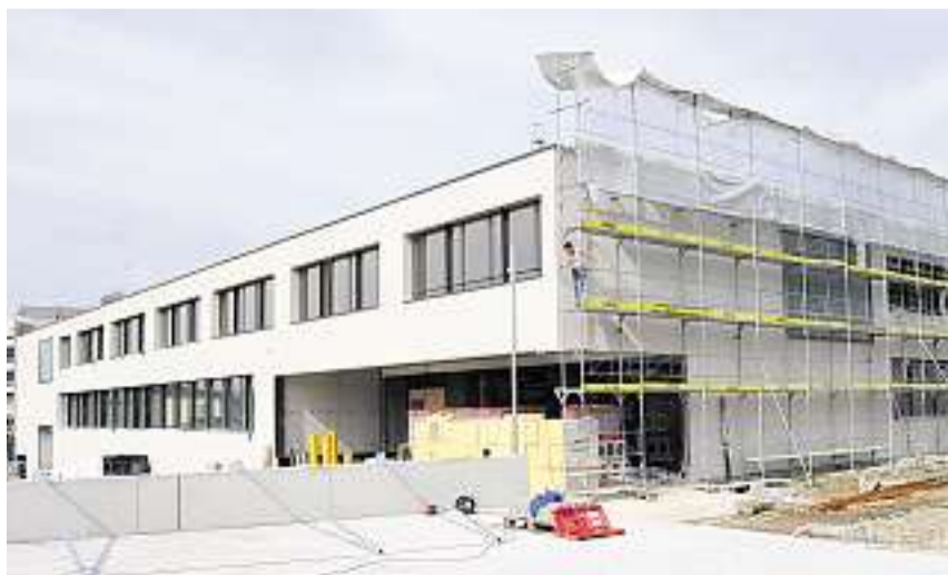
Ohne Gerüst sichtbar: Der 66 mal 39 Meter grosse Schulhaus-Monolith.
